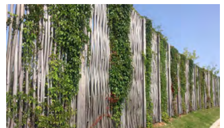
图 4 丹麦高速公路旁的 Pilebyg 隔音屏障。
